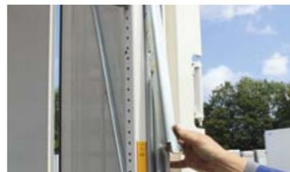
Con l'ausilio di un connettore l'altezza del tetto viene regolata in passi da 50 mm.
